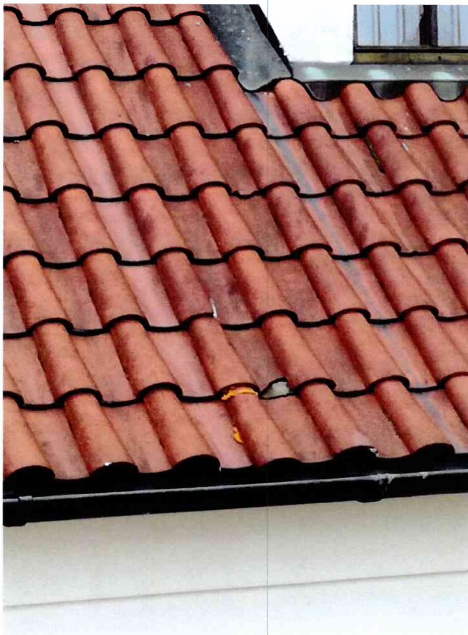
Obr. 6 – Detail prasklé krytiny - riziko zatékání
