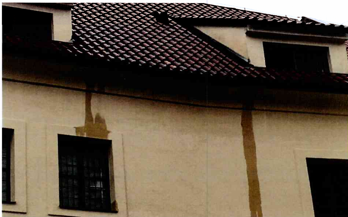
Obr. 15 – zatékání v okapní hraně
