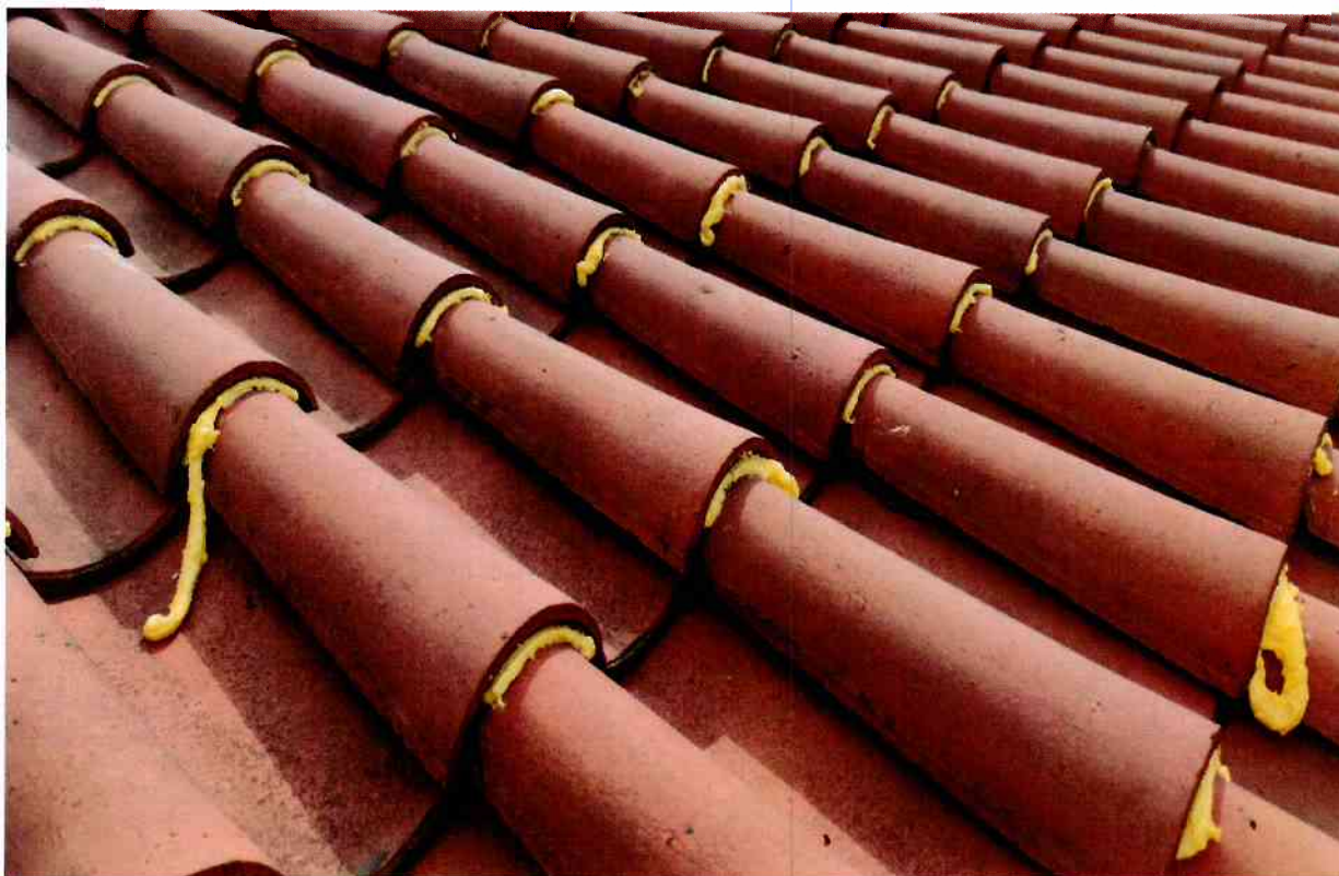
Obr. 11 – Opravy PUR pěnou
