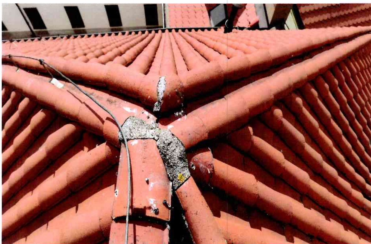
Obr.14 – Uvolněné malta propojení nároží a hřebene
