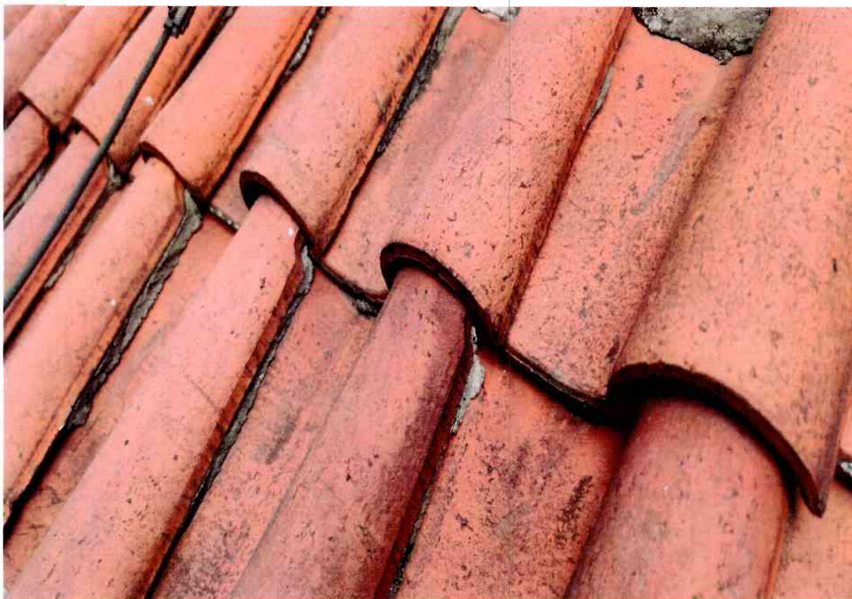
Obr. 18 – místy nedostatečné přesahy krytiny
