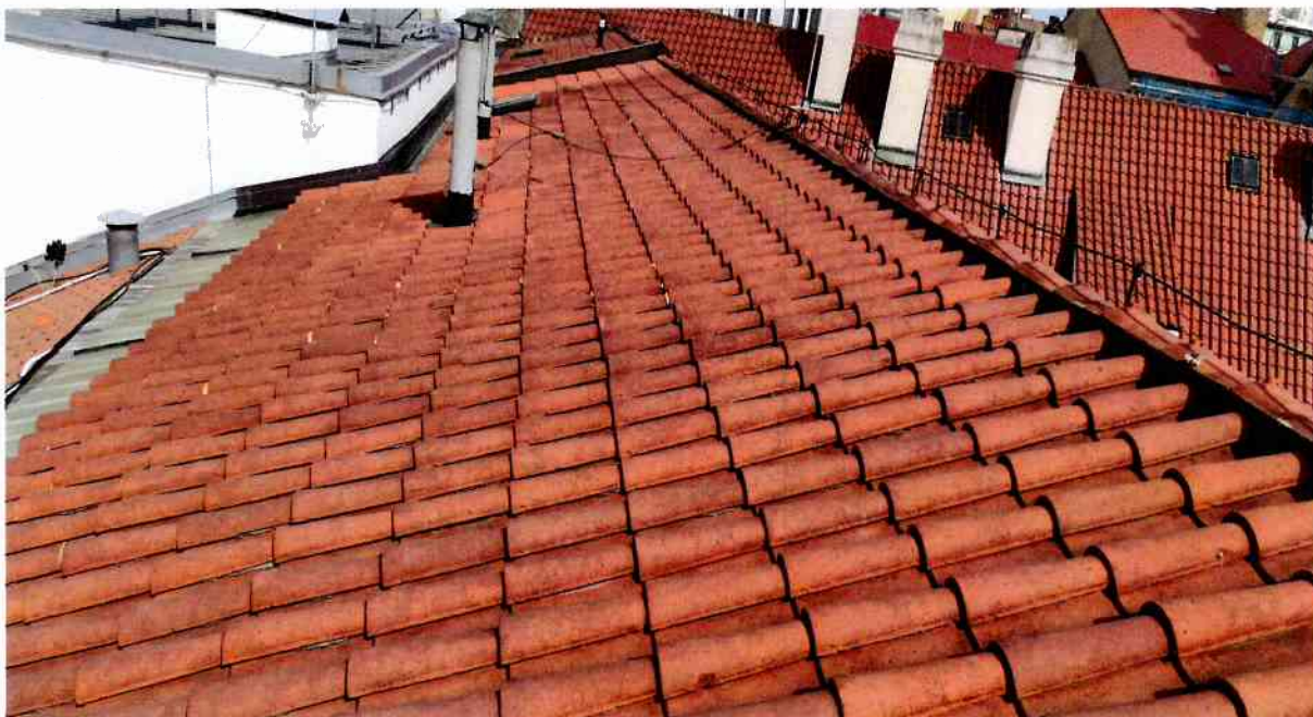
Obr. 19 – nedostatečný sklon střechy pro prejzovou krytinu
