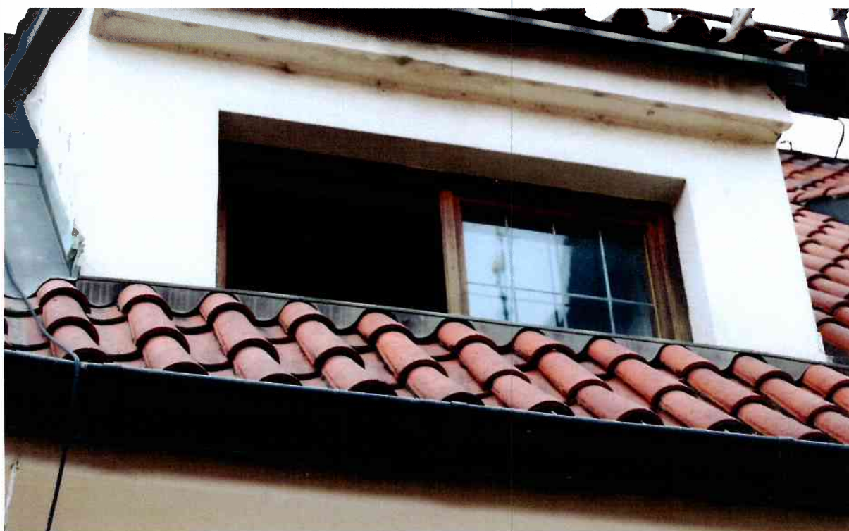
Obr. 21 – detail čela vikýře a plechování
