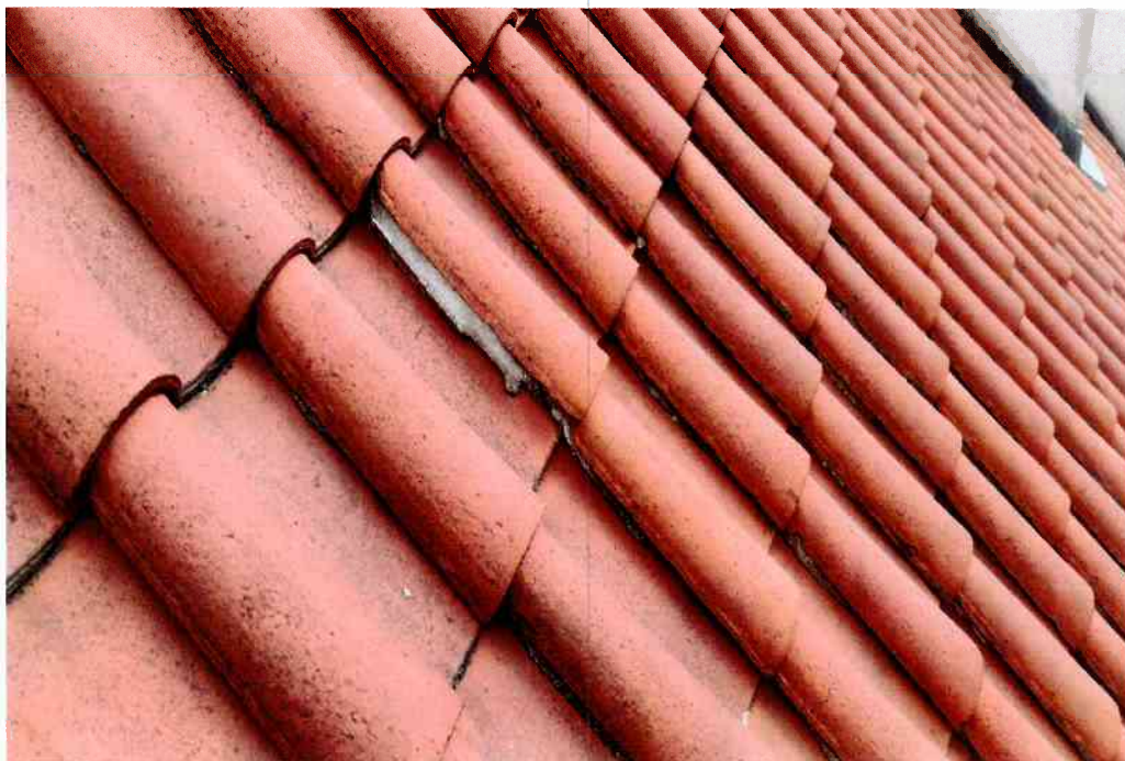
Obr. 7 – Uvolněné prejzy v ploše střechy
